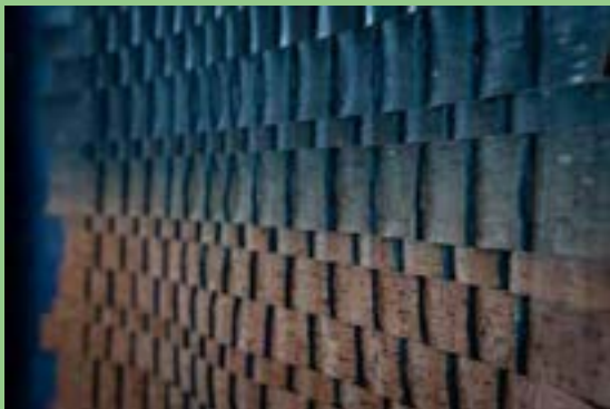
Tryptique tissé - AFA architecture - siège des bureaux Parisiens -modèle déposé- Atelier Loxiale- Lucile DROUET
